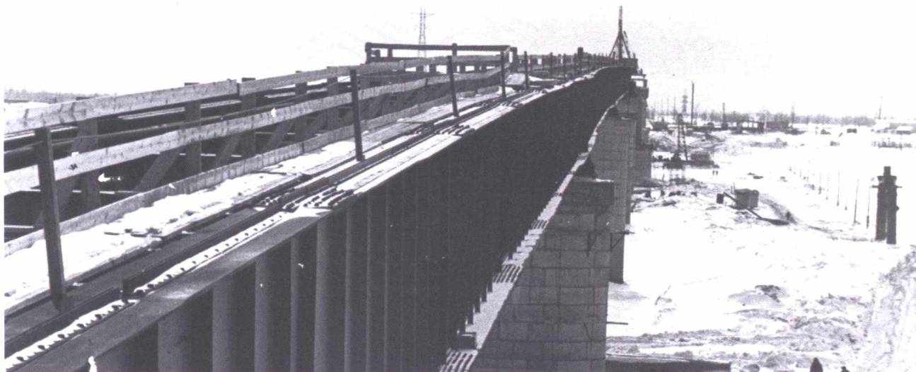
Мостостроители Юганской Оби наводят мосты
