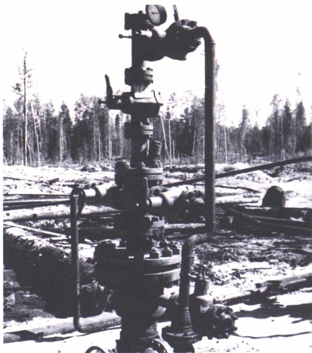
Одна из первых газлифтных скважин Правдинского месторождения. Альбом с фотографиями НГДУ «Правдинскнефть»
