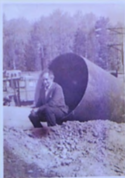
Укладка трубы под дорожку
