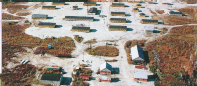
Строительство вахтового поселка «Белый Яр».
