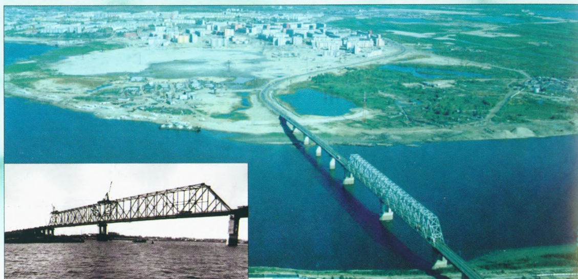
Мост через Юганскую Обь.
